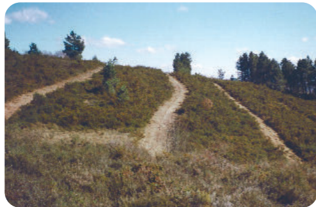
Vista general de un desbroce
