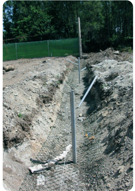
Zanja externa con protección anti-fuga.
