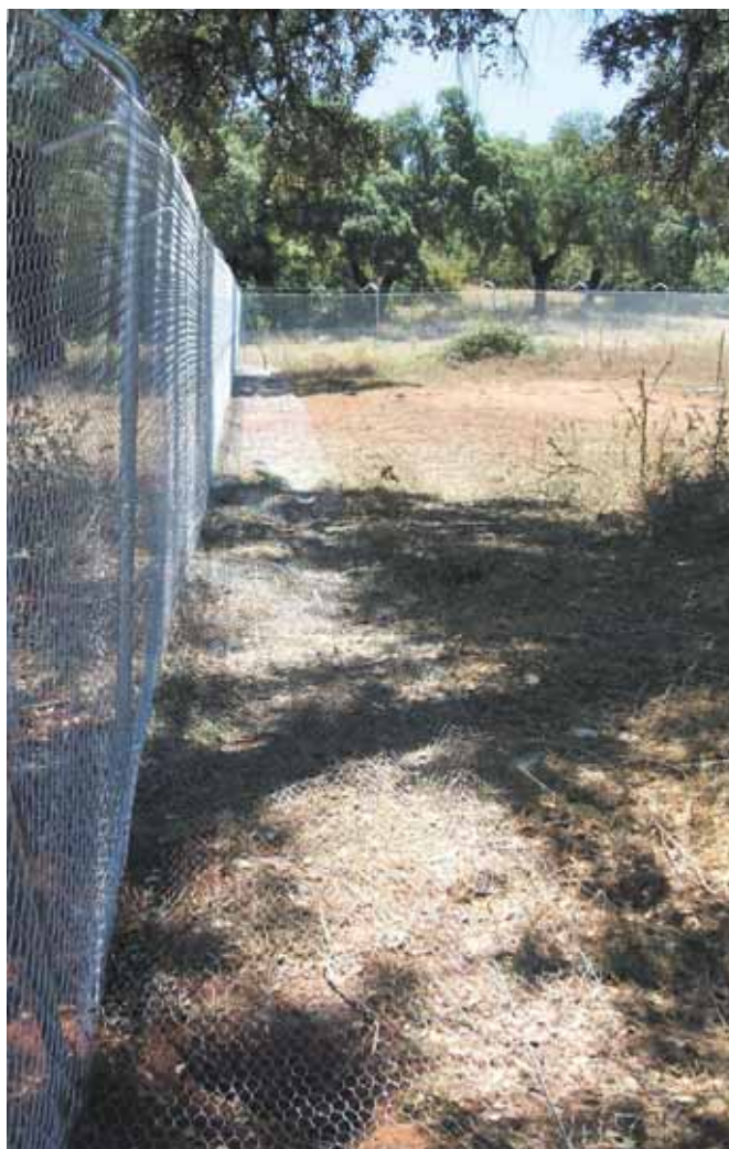
Foto 2. Detalle de un cerramiento de exclusión de depredadores terrestres.
