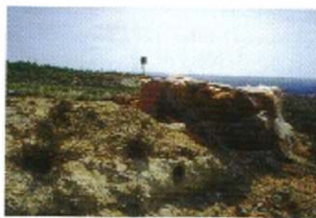
Refugio de tierra y pajas de paja sin enterrar transformado en madriguera por los conejos.
