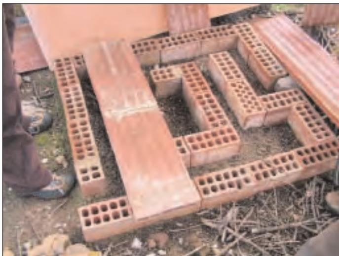
El principal factor que condiciona el éxito de un vivar de tubos es su capacidad de drenaje (Muñoz, 2005). Un vivar de tubos se puede inundar por escorrentía superficial, entrando el agua por las bocas del vivar o por flujo subsuperficial, formándose una bolsa de agua en el subsuelo que sumerge la estructura de cámaras (total o parcialmente). Para que esto no suceda es necesario:
