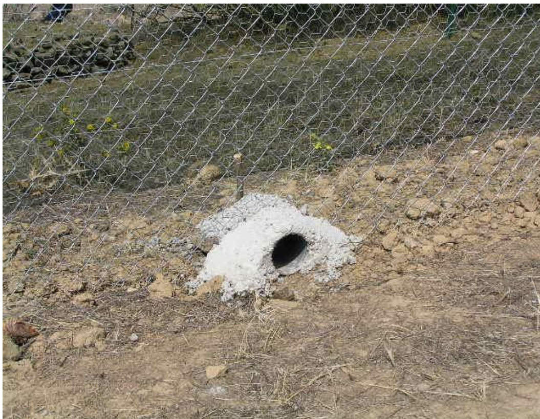
Foto n° 3. Detalle de abertura para entrada y salida de los conejos.
