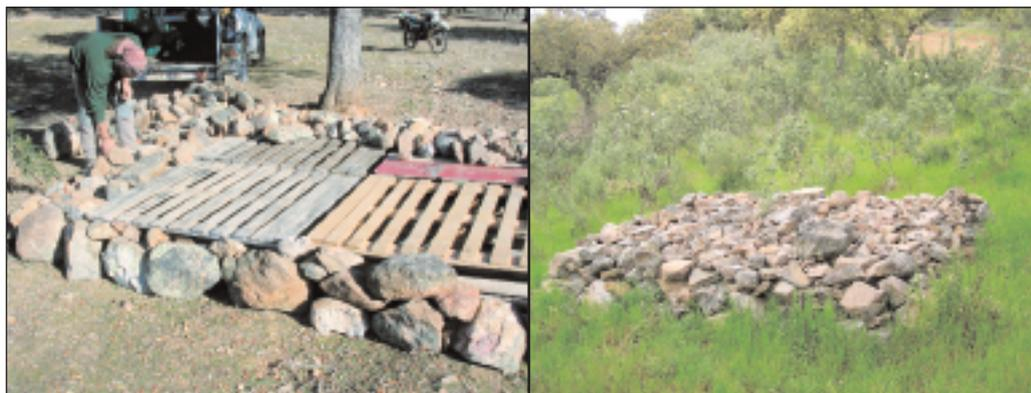
Figura 7.19. y 7.20. Proceso constructivo de majano de varios pisos y majano de palets y piedra terminado.
