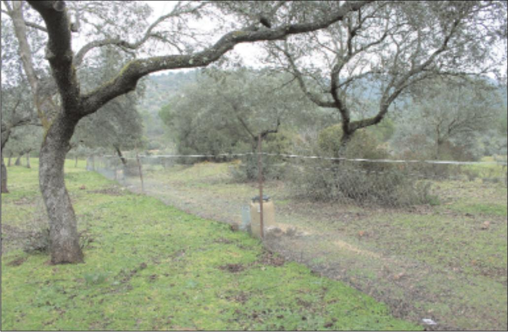
Figura 7.40. Cercado de repoblación con malla de simple torsión y conejera en la parte baja en área de presencia estable del lince ibérico
